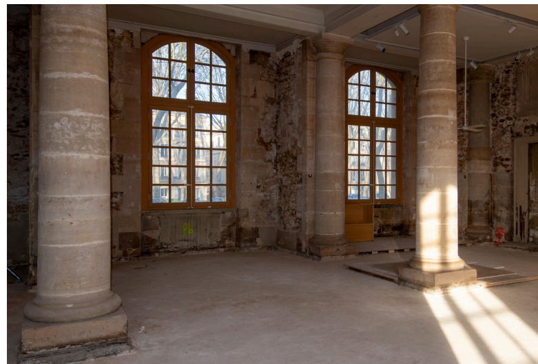
Aile de Saint-Cloud avant les travaux
