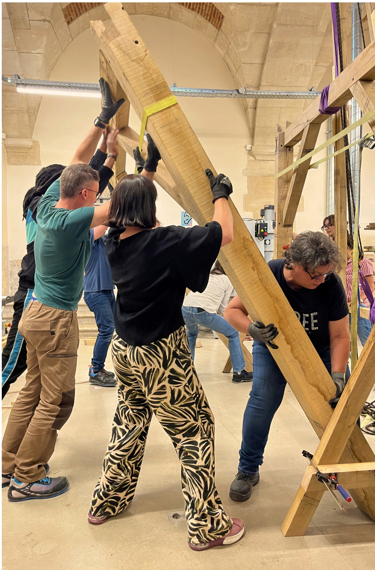
Formation Piima Bois promo 2025, levage de la charpente réalisée dans le cadre de la fabrication d'un abri pour le Potager du Roi
